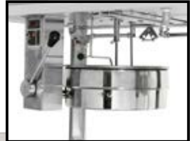
ANSUL Discharge Nozzles
